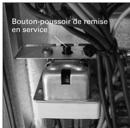
Figure 3. Protection contre la surchauffe
