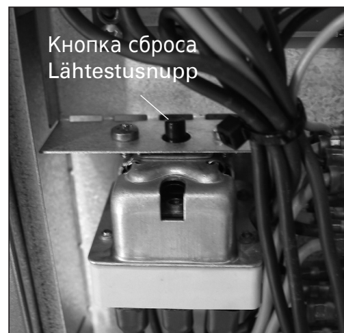
Рис. 3. Защита от перегрева Joonis 3. Ülekuumenemiskaitse
